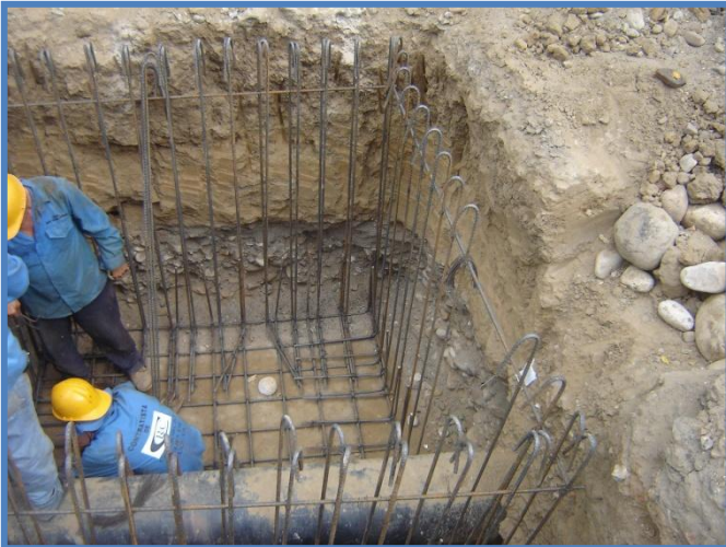
Figura 7. Construcción Caja de Macromedición
