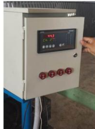
Sistema de Termocuplas a Instalar
